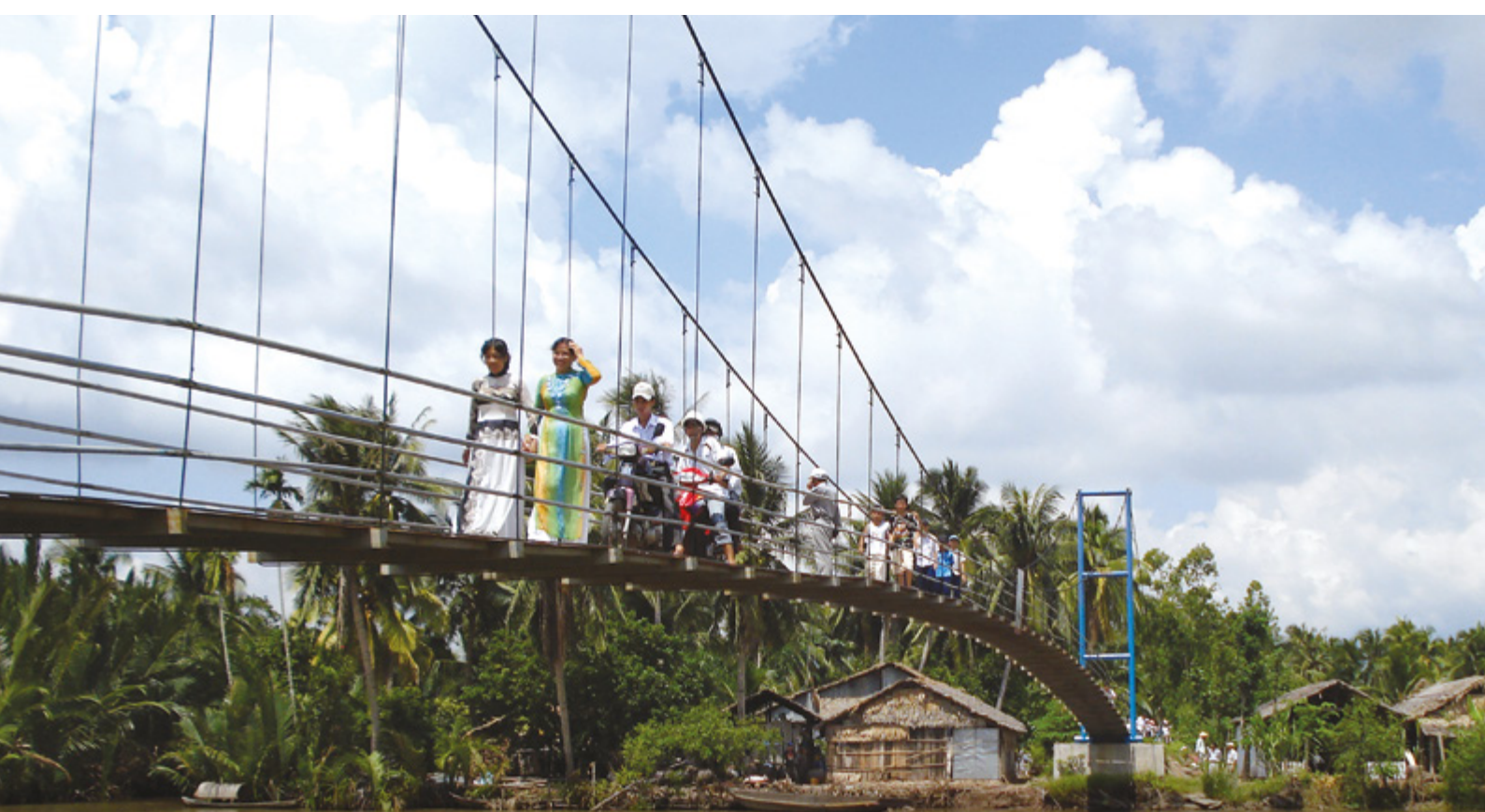
PUENTE EN CAMBOYA – (ABAJO)
